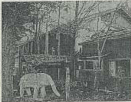
「福祉のむら」拠点施設となる湯沢市の旧坊ヶ沢小体育館。右子前は取り進められる校舎
