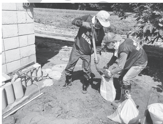
土のう袋に泥を詰める
