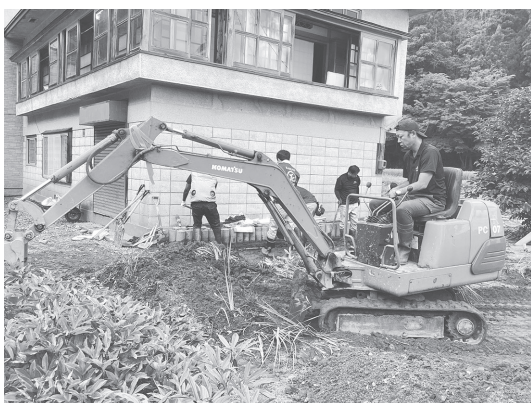
重機を使つての泥出し
