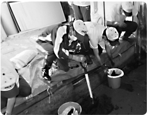
床下の泥出しの様子
